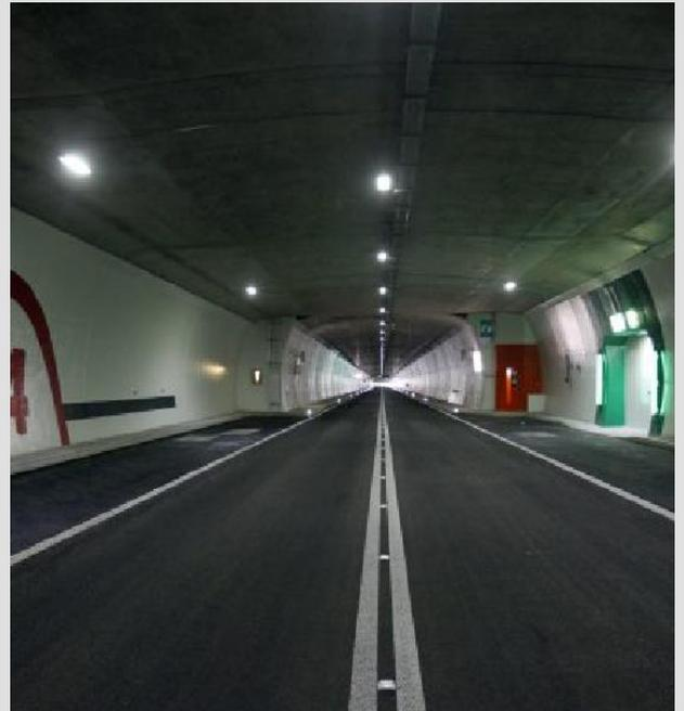
Mit dem Neubau des Umfahrungstunnels Lungern hat das Bundesamt für Strassen ASTRA den ersten Tunnel in der Schweiz komplett mit LED-Beleuchtungstechnologie ausgerüstet.
