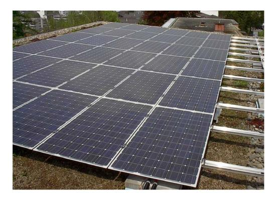
Die **AluFlatClips** - Befestigung wurde zur effizienten Montage von Modullaminaten unter Vermeidung von Klebestellen und Schraubverbindungen entwickelt.
