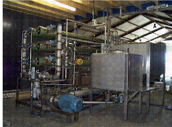
**Abbildung 11:** Links: Ultrafiltrationsanlage auf einem Mastschweinebetrieb. Vorne links die Förderpumpe mit den Membranmodulen, anschliessend Reinigungs- und Arbeitsbehälter. Rechts: Umkehrosmoseanlage auf einem Mastschweinebetrieb. Im Hintergrund links sind die Membranmodule zu sehen.
