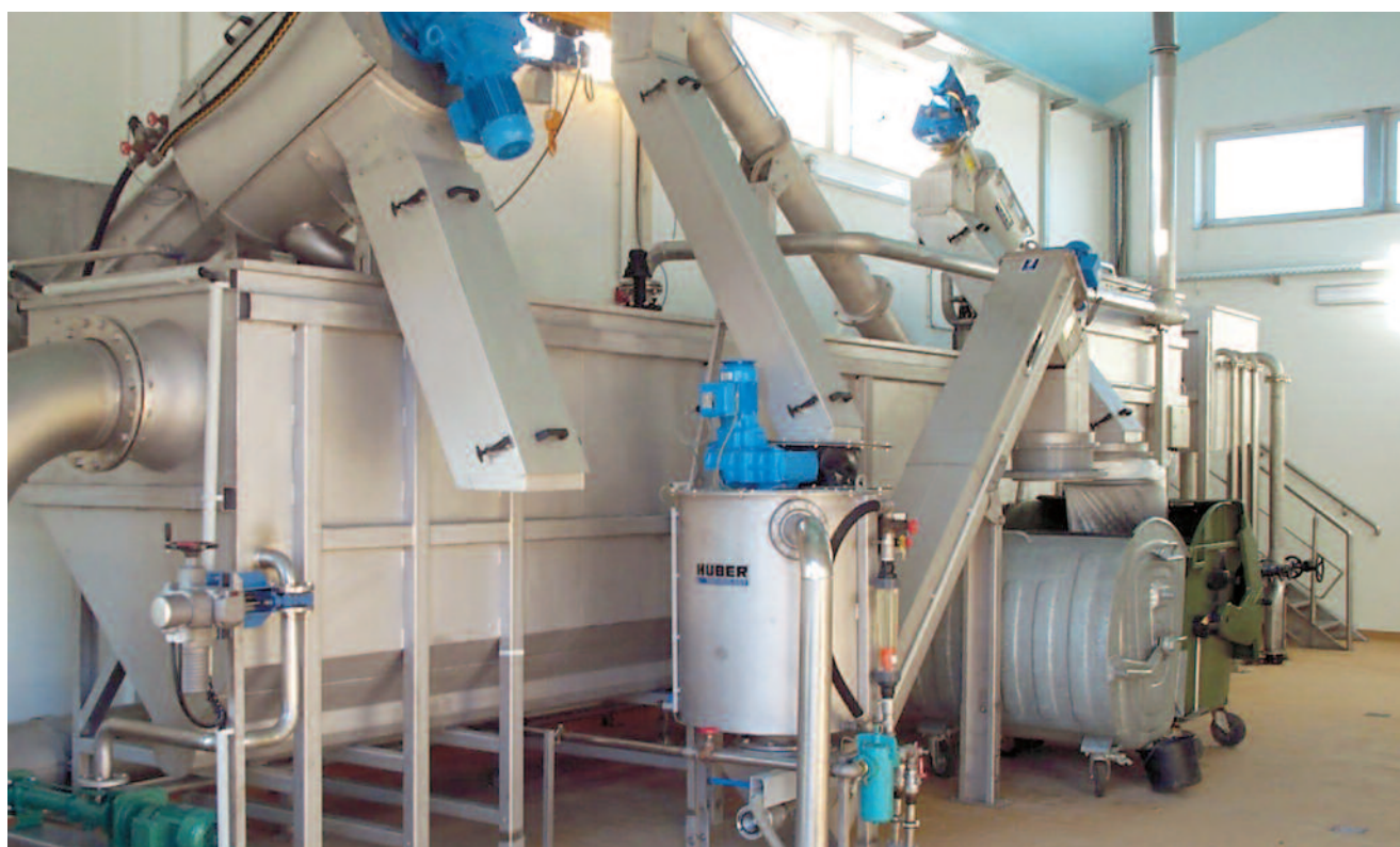
Anwendungsbeispiel: HUBER Trommelseparator eingebunden in einem Langsandfang
